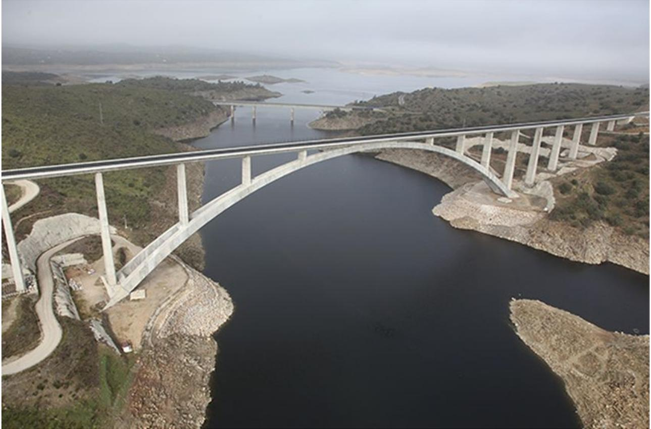
*Viaducto Almonte-LAV. Longitud de 996 metros, proyectado con un vano central de tipo arco de hormigón inferior, de 384 metros de luz, récord mundial de luz en su tipología de arco para uso ferroviario de alta velocidad.*
